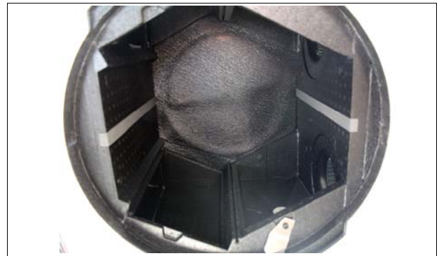
Abb. 8.4 Innenansicht Lüftungsgerät (ohne Wärmetauscher)
