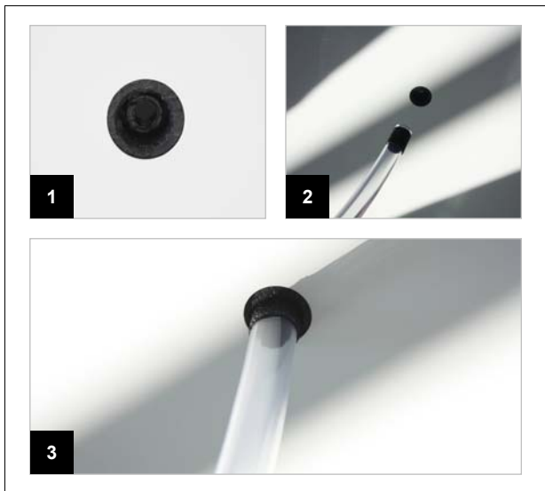
Abb. 4.3 Installation Kondensatschlauch
